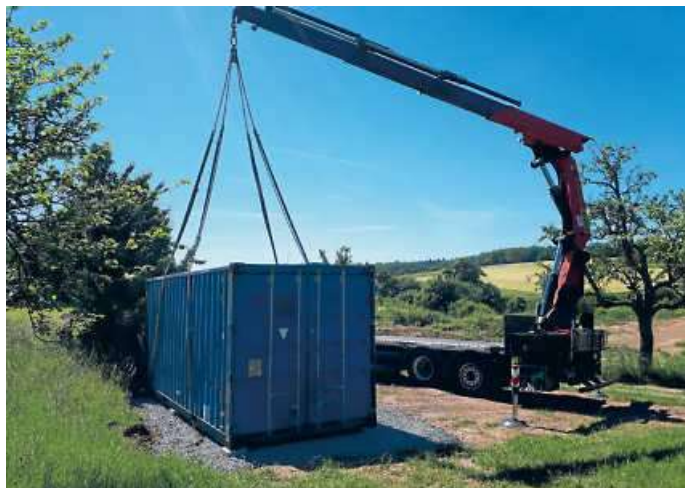
Pumptrack-Container wird auf dem vorbereiteten Schotterbett per Kran platziert Fotos: MSCO
